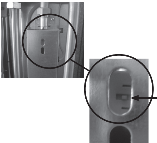
Sicherheitstemperaturbegrenzer und Reset-Knopf (Pfeil)
