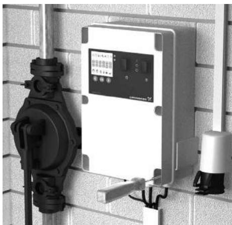
Abb. 8 Anbringen der Steuerung LC 221
